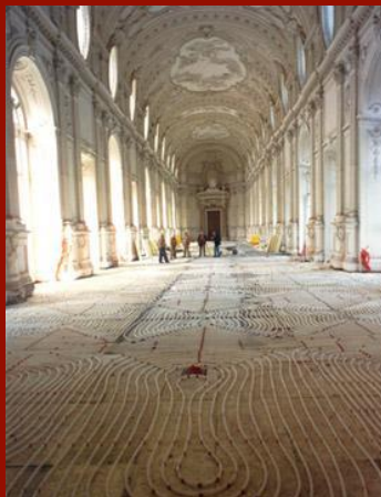
Reggia di Venaria, Galleria di Diana, impianto di riscaldamento a pavimento.
