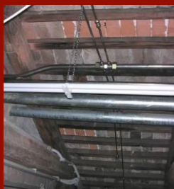
Venezia, Palazzo reale, Museo Correr - sistema di spegnimento automatico degli incendi ad acqua nebulizzata ad elevata pressione, installato nelle soffitte.
